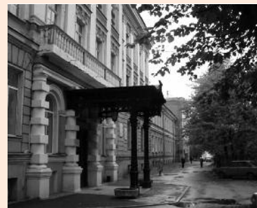
Современный вид фасада здания, в котором располагается кафедра психиатрии ВМА.
